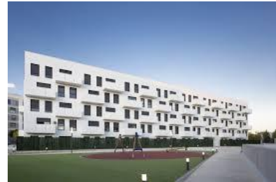
Vivienda accesible, sostenible y de rápida provisión
